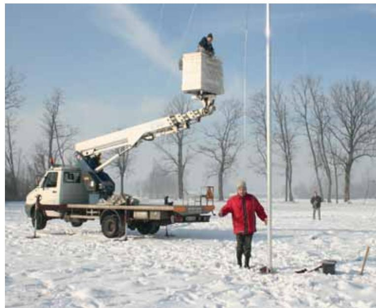
Postavljanje sistema štirih faziranih vertikalk za 1,8 MHZ v Skorbi
